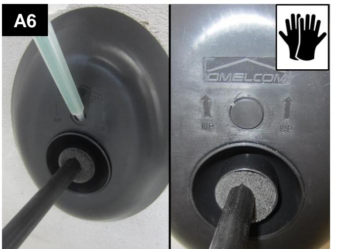
Tragen Sie bei der Nutzung der Spritze Schutzhandschuhe. Installieren Sie den Mischer auf der Spritze und injizieren Sie das 2K-Dichtungsmittel vollständig in das vorgesehene Loch. Verschließen Sie das Loch mit dem Stopfen.
