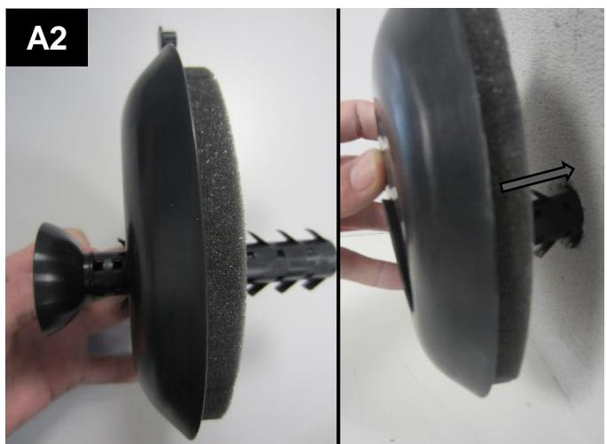
Bauen Sie den Dübel und den Flansch zusammen. Richten Sie den Flansch so aus, dass die Einspritzöffnung oben ist, Pfeile zeigen nach oben. Drücken Sie das System in die Bohrung, bis der Flansch an der Wand anliegt.
