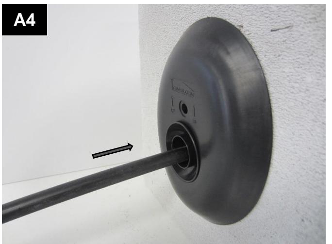
Führen Sie das Kabel/SNR durch die Wand über das System bis zum Anschlusspunkt.
