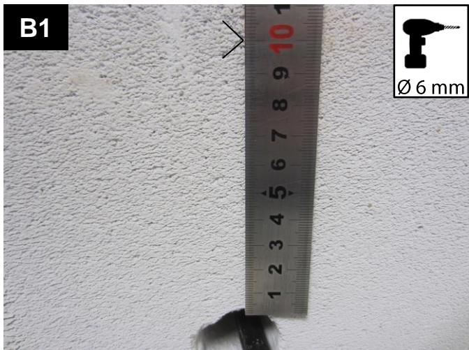
Bohre das Befestigungsloch, Ø6mm, 10 cm vom Rand des Durchgangslochs entfernt in der Biegerichtung des Kabels.
